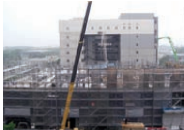
6月10日に撮影した工事現場
