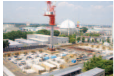
総合研究実験棟の工事現場
