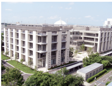
第2総合研究棟の外観
