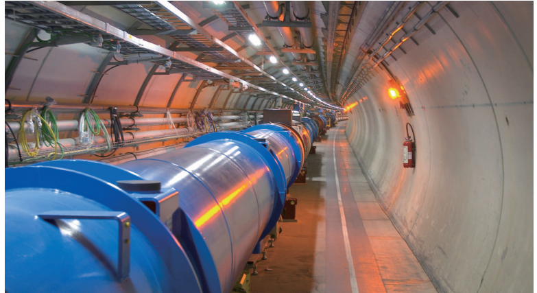
図4 LHC加速器のトンネルに最初に設置された電磁石 Copyright © CERN, Photograph by Maximilien Brice
