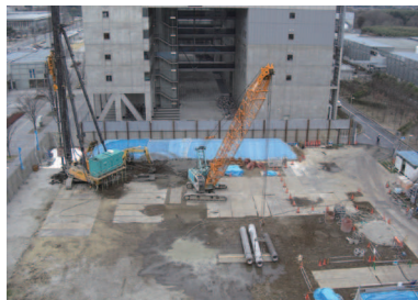
研究棟の工事のようす
