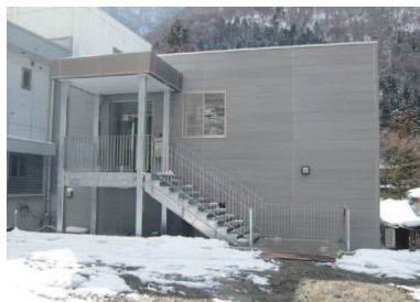
神岡サテライト研究棟の外観
