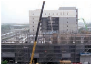
6月10日に撮影した工事現場
